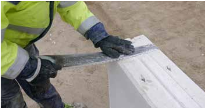
Aussparungsfräsen für Montageanker
