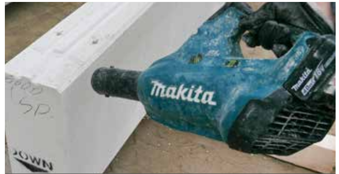
Reinigen Sie die Plattenoberfläche nach dem Fräsen von losen Rückständen
